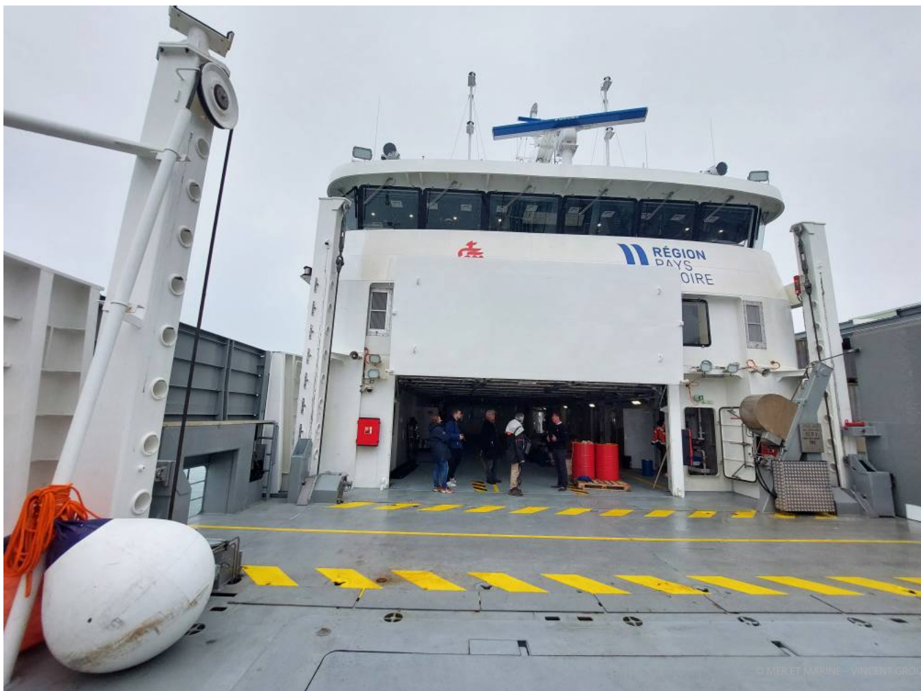
Le pont extérieur à l'avant permet de stocker du fret et donne directement sur le garage.
